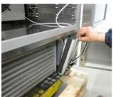
Retirer les vis de blocage du tableau électrique.
